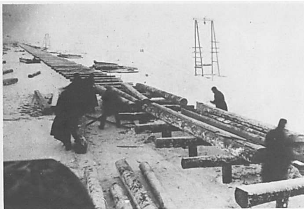
УКЛАДКА ПРОГОНОВ НА УЧАСТКЕ 40-го Ж. Д. БАТАЛЬОНА.
